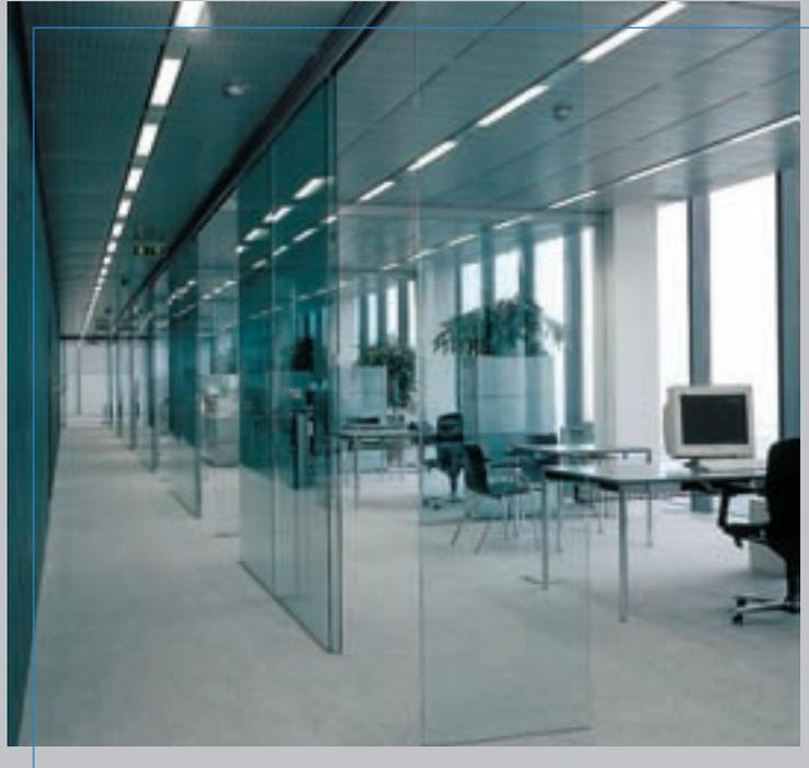
Die obere Führung erfolgt mittels Kugel gelagerten Rollen bei unten und seitlich freier Glaskante. Die Laufschiene kann wahlweise an die Wand oder unter die Decke montiert werden.
